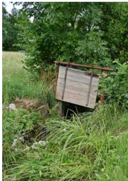
Mittels Staubrett wird Wasser abgeleitet.
